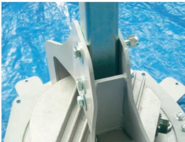
DESATORNILLAR LOS TORNILLOS DE FIJACIÓN
